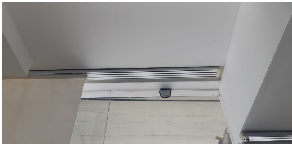
Foto 01 - As cortinas serão fixadas em forro de gesso.
