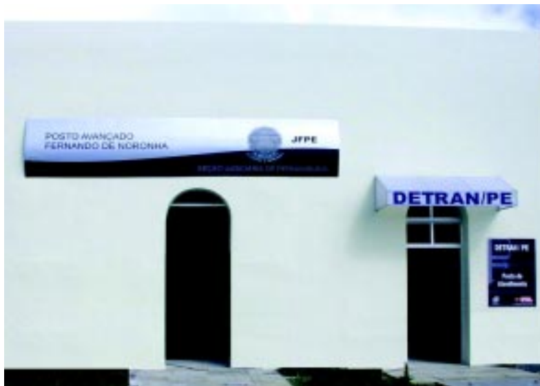
Posto de Atendimento Avançado de Fernando de Noronha / PE
