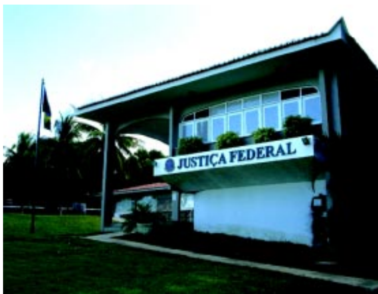
Vara Federal instalada em Juazeiro do Norte/CE
